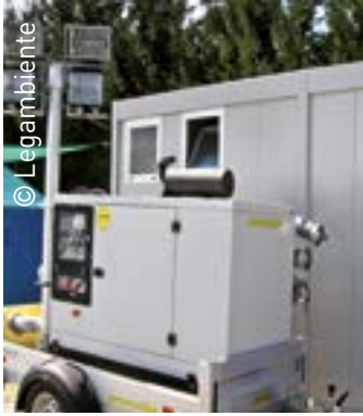
Bir çadırkentte elektrik jeneratörü
