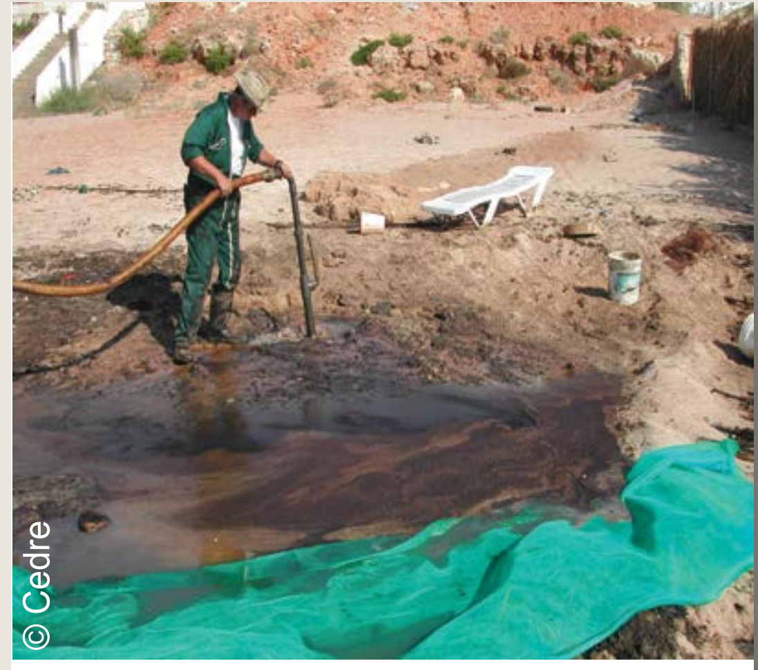
إثارة الرواسب بإستخدام ضغط ماء منخفض
